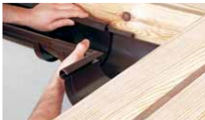
Рис.14 Монтаж угольников желоба
