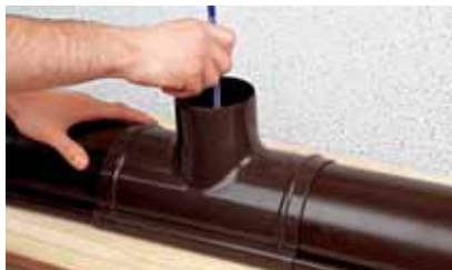
Рис.13 Установленная водосточная воронка
