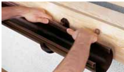
Рис.10 Монтаж вкладки в муфту желоба
