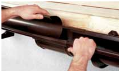
Рис.11 Разметка места под воронку
