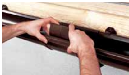
Рис.12 Вырезание отверстия под воронку
