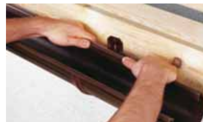
Рис.9 Монтаж муфты желоба
