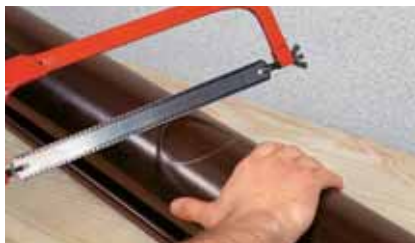
Рис.14 Монтаж угольников желоба
